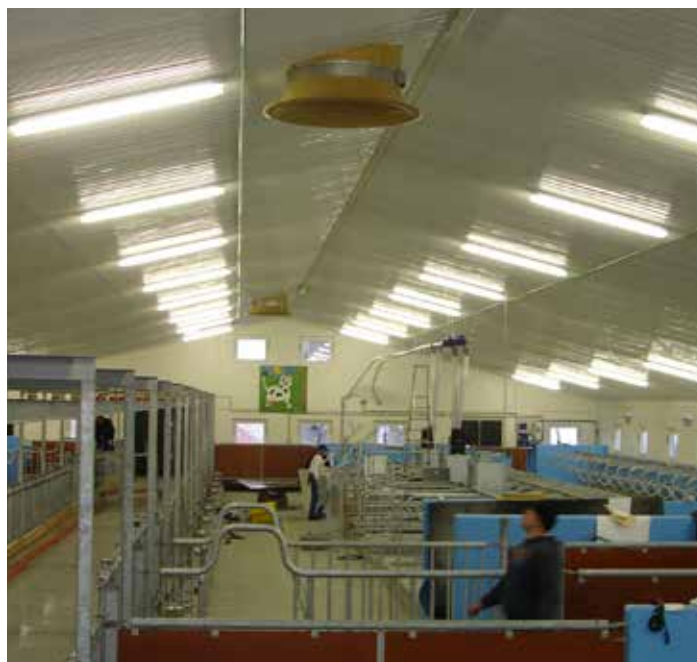
Ideell plassering av lysarmaturer og takprofiler for at luften kan klebe seg uhindret til taket.
